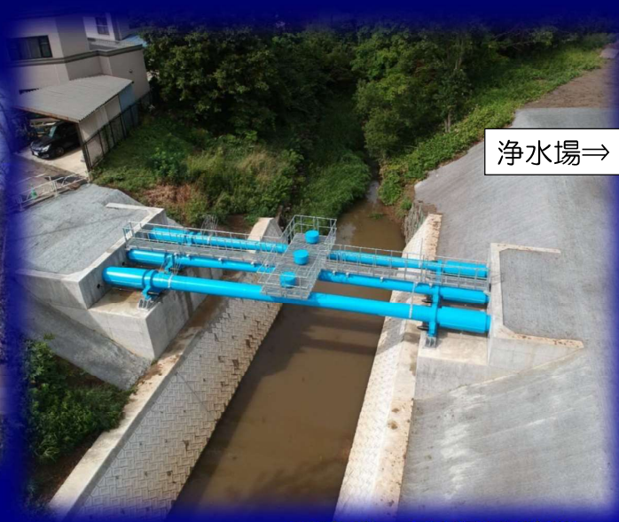
R3完成 早苗別水管橋
