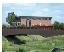
早苗別排水機場
