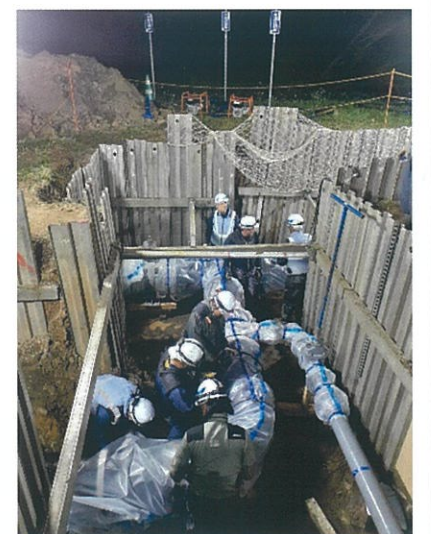
⇨ 古くなった下水道管を更新する工事の様子（深さ約4m）
