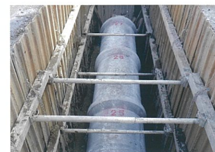
⇨ 古くなった下水道管を更新する工事の様子（深さ約4m）
