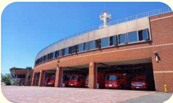
消防本部庁舎
