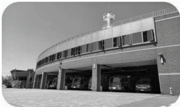
消防本部庁舎
