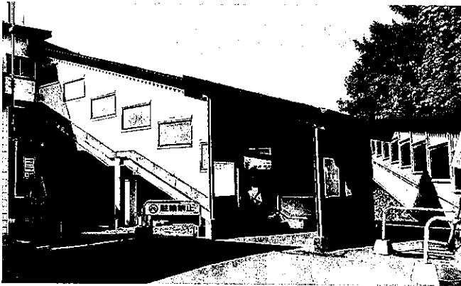
大麻駅跨線人道橋（北口）
