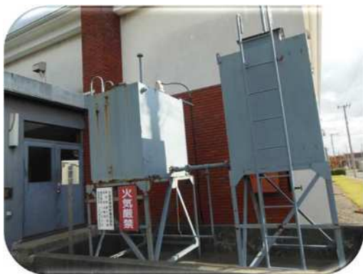
郷土資料館設備更新事業（重油タンク更新工事）
