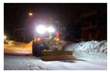
新雪除雪（除雪ドーザ）
