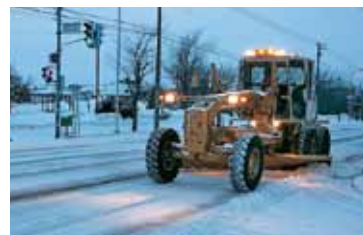
路面整正 (除雪グレーダ)
