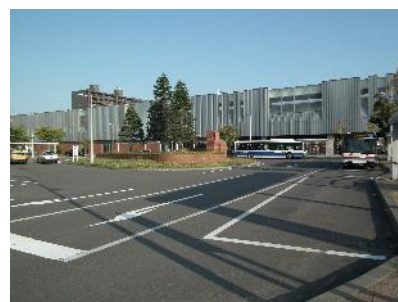
▲野幌駅前北口広場
