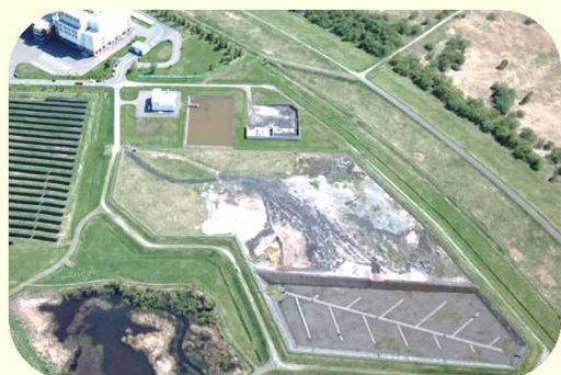
第1期最終処分場
