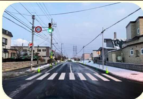
改修した兵村4丁目通り
