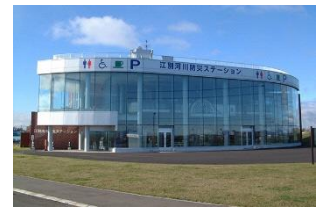
河川防災ステーション
