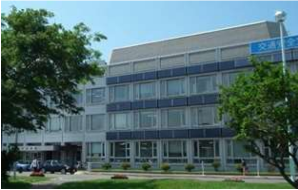
〈市役所本庁舎に設置している太陽光パネル〉
