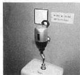
男子小便器光電センサーの修繕
