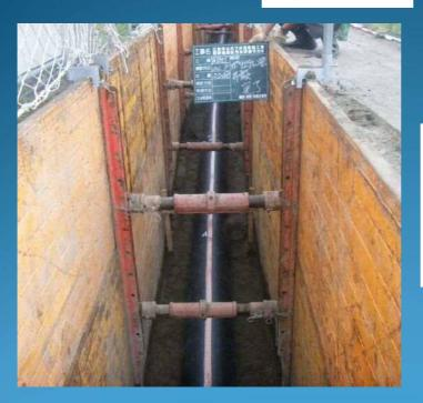
地盤を掘削し所定の 位置に管を布設する。 通常、既設管を撤去し 同じ位置に新設管を 布設する。
