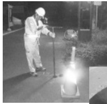
洗管作業の様子
